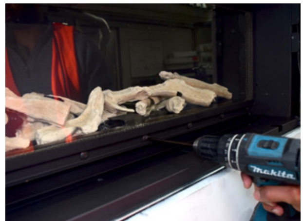
Remove door screws
